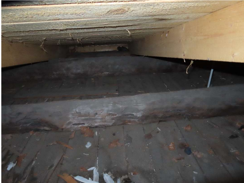
12. Verandos stogo ir perdangos konstrukcijų fragmentas.
