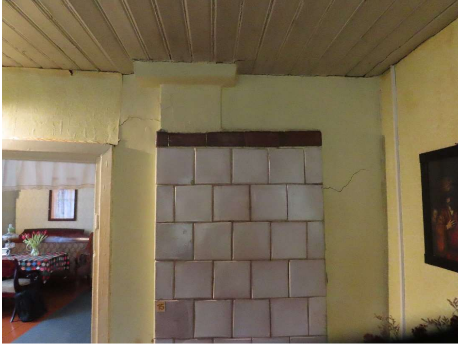
7. Mūrīnēs 0,5 plytās storio sienas mūrē atsivērē horizontalūs įtrūkimai.
