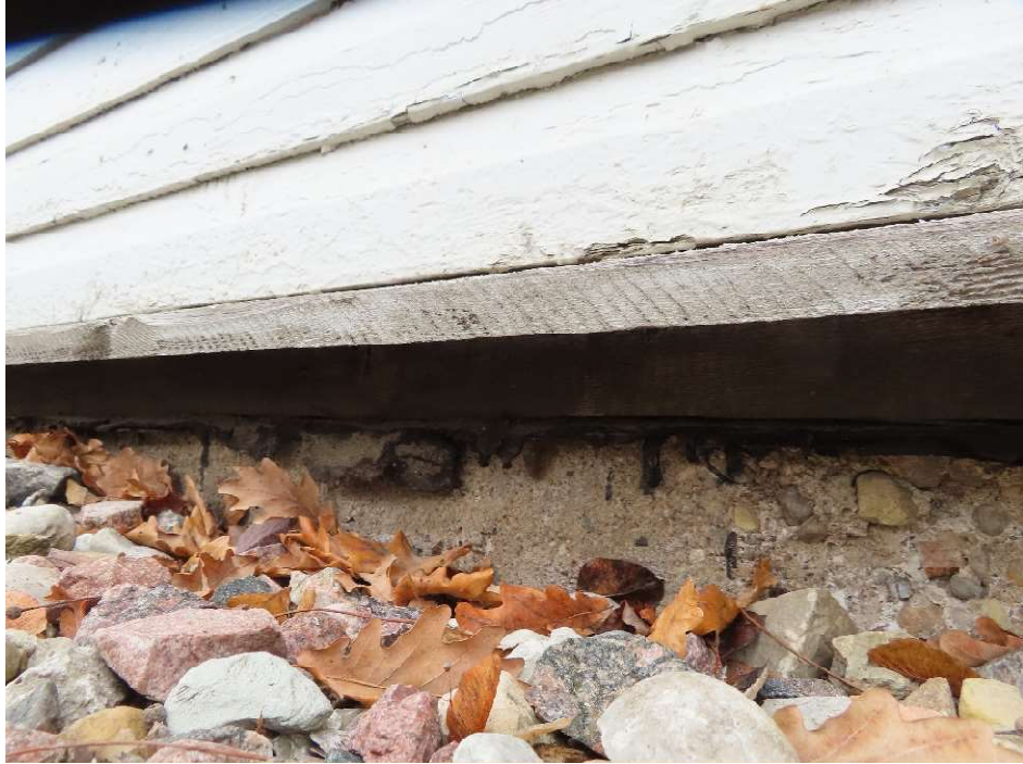
5. Tarp betoninio pamato ir sienų įrengtas ruberoido sluoksnis.
