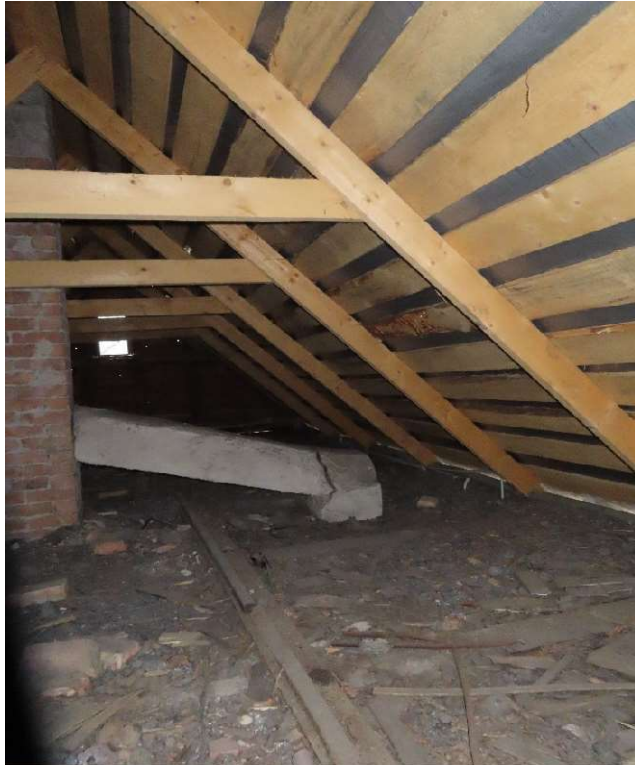
10. Sodybos muzikos namo stogo laikančios gegnės 145(h)x50 mm išdėstytos ~1,4 m žingsniu. stogas įrengtas konstrukcijos fragmentas.
