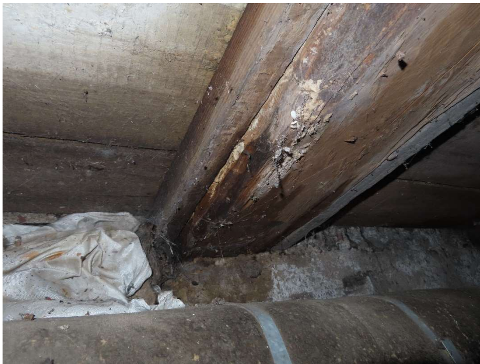
19. Rūsio perdangos medinių sijų galai įrengti be hidroizoliacijos sluoksnio, sijų galai drėgni ir pažeisti puvinio.
