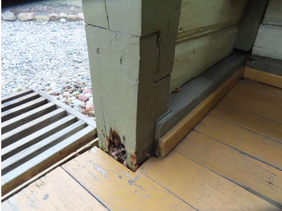
17. Prieangio remontuotų medinių statramsčių apatinės dalys dėl pastovios drėgmės pažeistos puvinio.
